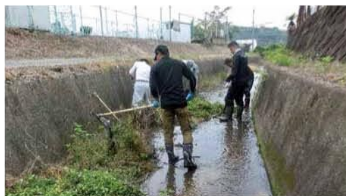
水路の泥上げ
