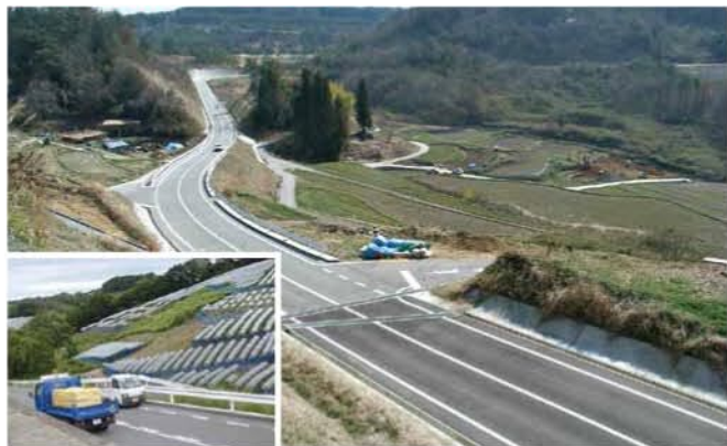
広域農道 備前東部2期地区（和気町）
