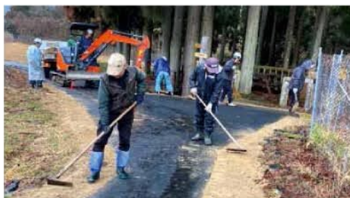
長寿命化（農道のアスファルト舗装）
