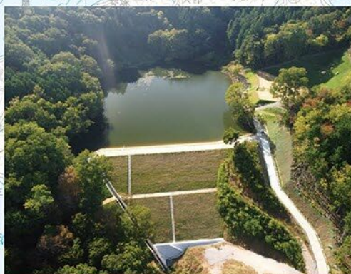
ため池等整備事業（山ノ田池地区）
