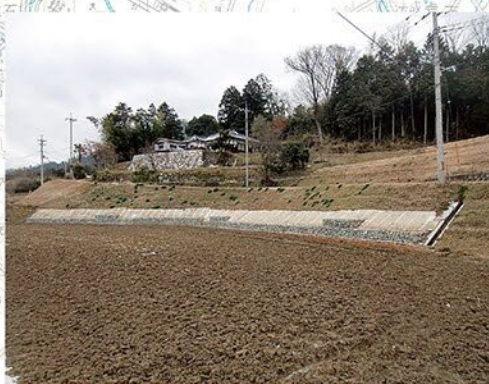
地すべり対策事業（津山市東部地区）
