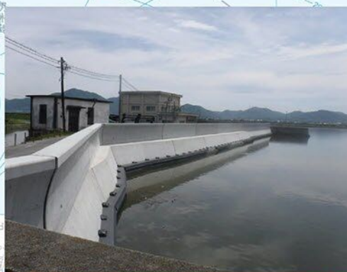
海岸保全施設整備事業（児島六区地区）
