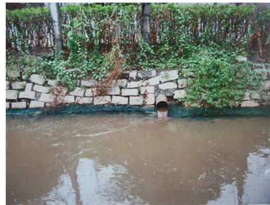
図 2: Thi Vai への未処理排水の排出パイプ
