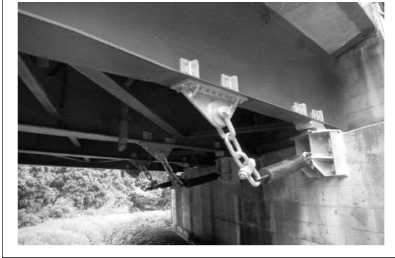
耐震補強状況
