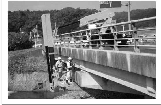
橋梁点検状況
