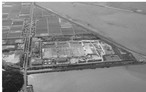
児島湖流域下水道浄化センター
