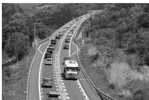
中国横断自動車道岡山米子線 （暫定2車線区間）
