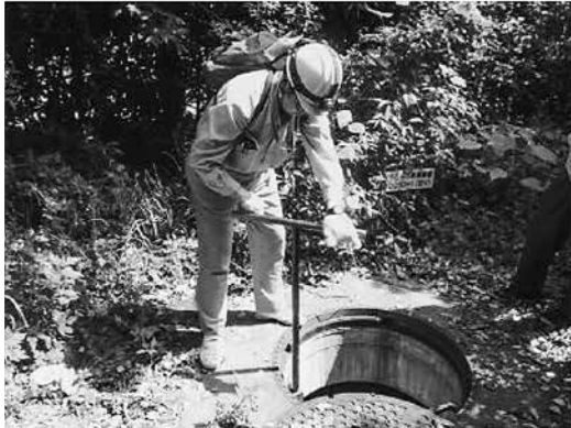
2ルート配水管路の切替作業状況
