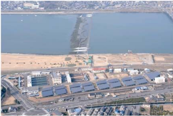
工業用水道事務所 (西之浦浄水場)
