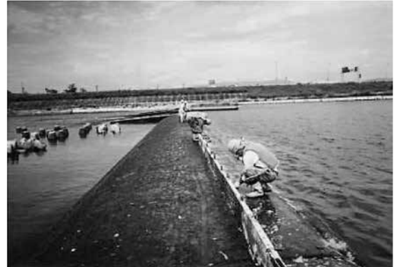
パネル設置作業状況
