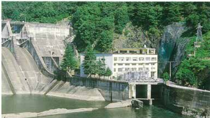
ダム直下の第一発電所
