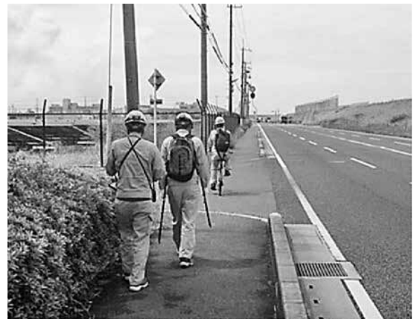
徒歩・自転車による管路点検
