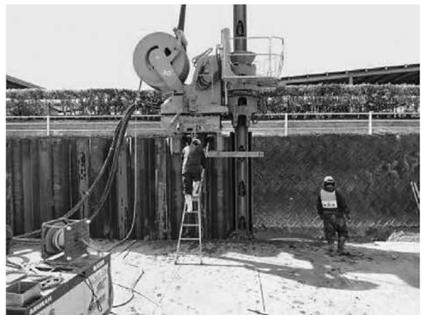
耐震化工事例：西之浦浄水場導水管路耐震化工事 工業用水の導水管布設箇所の液状化対策として、鋼矢板による擁壁を整備
