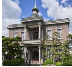
会場：城西浪漫館(中島病院旧本館)
