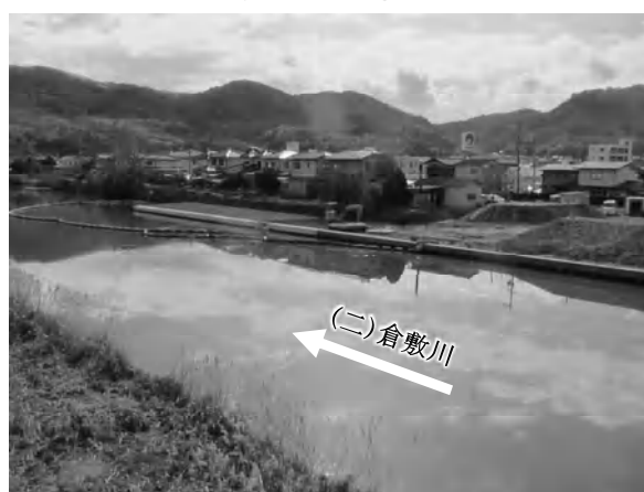
護岸施工状況
