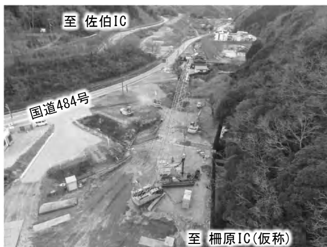
光木高架橋(仮称) P 3 橋脚施工状況
