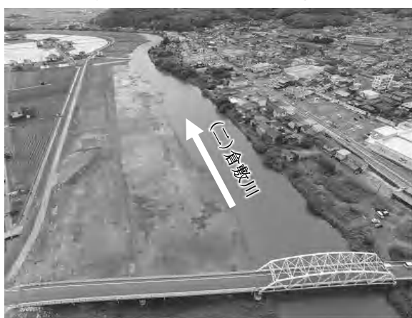
暫定河道掘削施工後状況
