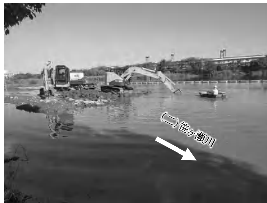
河道掘削状況
