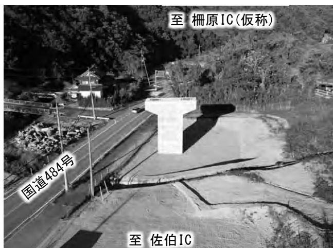
光木高架橋(仮称) P 1 橋脚完成状況
