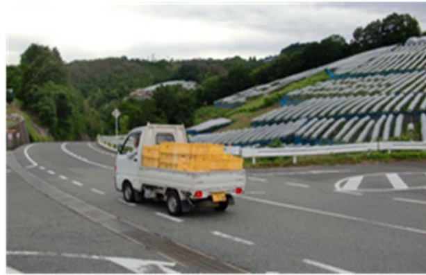
整備された農道
