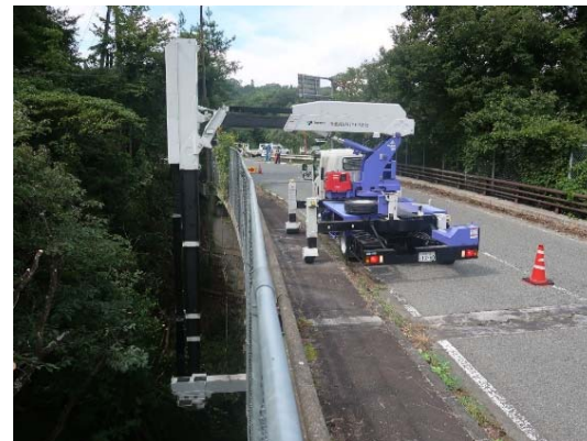
橋梁点検の状況
