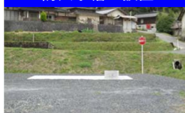
防火水槽の設置
