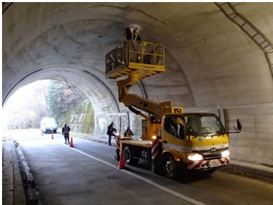
トンネル点検の状況
