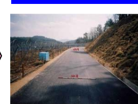
農地に隣接した農道整備
