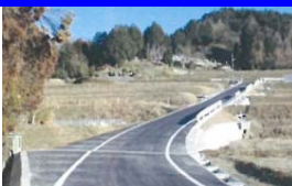
安全性が向上した集落道
