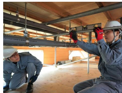
【トイレ・洗面器施工実習】
