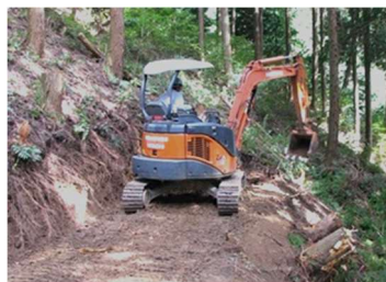
作業道の機能強化 （路面の補修等）
