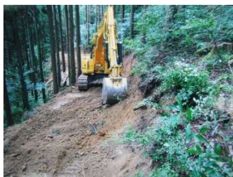
作業道の開設
