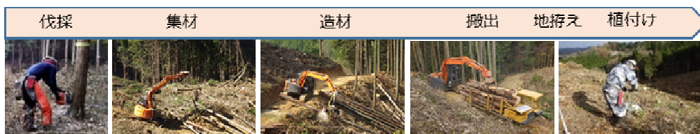
伐採・再造林の一貫作業
