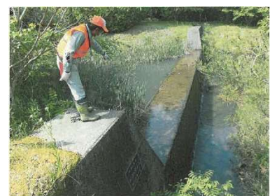
治山施設の点検
