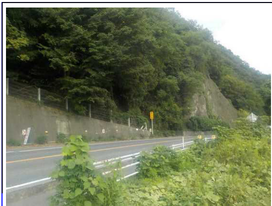
国道374号（整備前）
