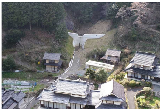
谷止工による荒廃森林の整備
