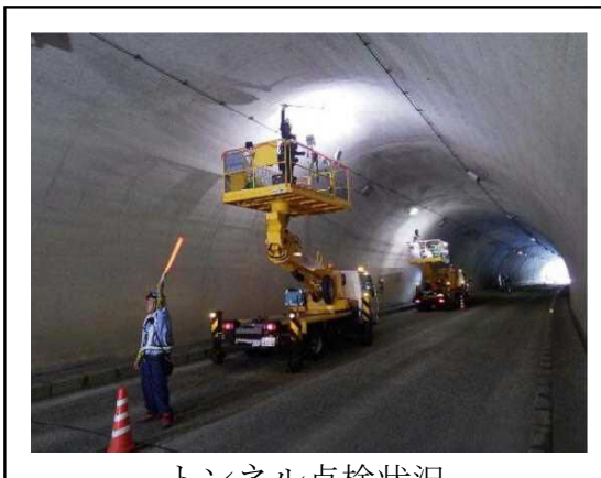
トンネル点検状況
