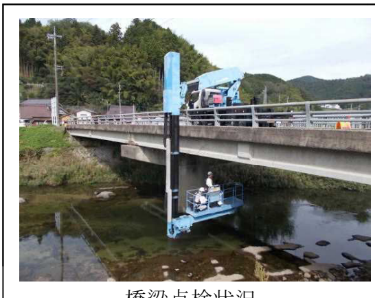
橋梁点検状況
