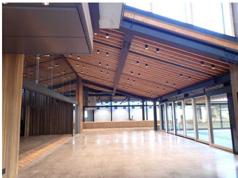
公共建築物の木質化(フローリング等)
