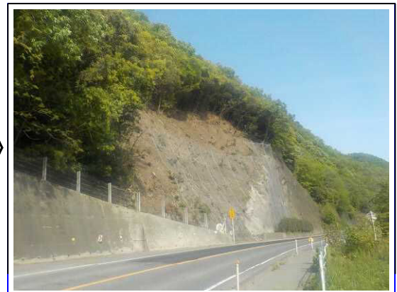
国道374号（整備後）
