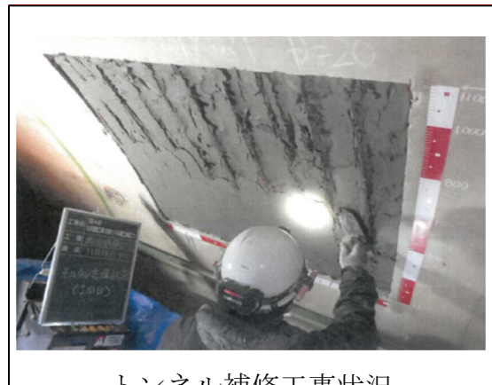
トンネル補修工事状況
