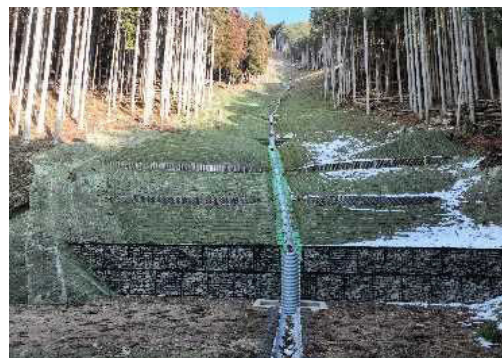
山腹工による荒廃森林の復旧
