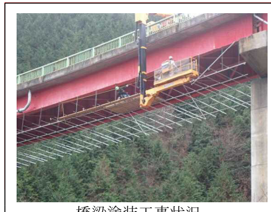
橋梁塗装工事状況
