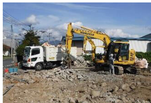
解体現場の様子
