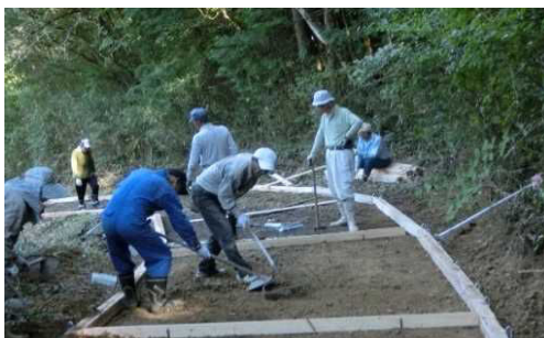
多面的機能支払（農道の舗装）
