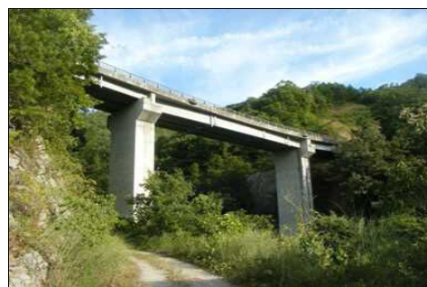
農道の保全対策(橋梁耐震補強)
