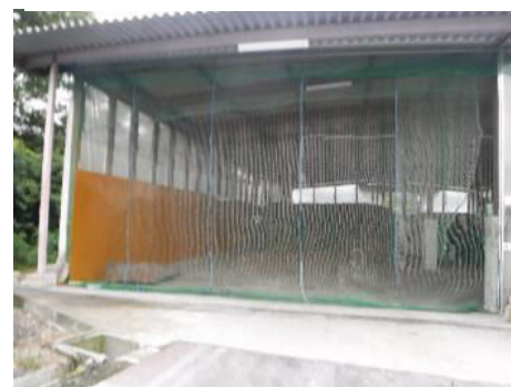
〈堆肥舎へ防鳥ネット設置〉
