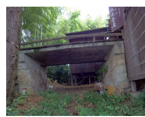
橋梁 コンクリート床版橋 (後楽園)
