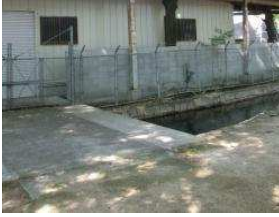
野球場 擁壁 (総合グラウンド)
