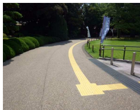
園路 舗装(カラーアスファルト) (後楽園)
