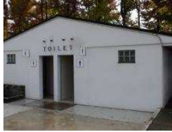
補助陸上競技場 トイレ園路北側 (総合グラウンド)
