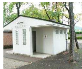
多目的広場 トイレ (総合グラウンド)
