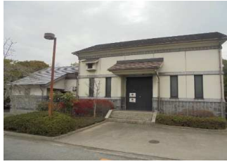
ポンプ室上屋 (倉敷スポーツ公園)
