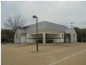
自由広場 休憩棟 (倉敷スポーツ公園)
