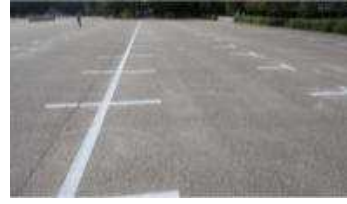
園路 舗装② (総合グラウンド)
