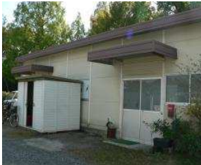
野球場 作業員詰所(野球場西 1) (総合グラウンド)
