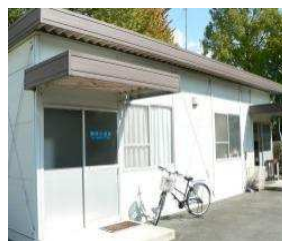
野球場 作業員詰所(野球場西 2) (総合グラウンド)
