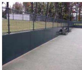
南テニスコート 擁壁(コート外周部) (総合グラウンド)
