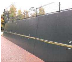
南テニスコート 擁壁(壁打ち) (総合グラウンド)
