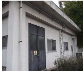
野球場 電気室 (総合グラウンド)
