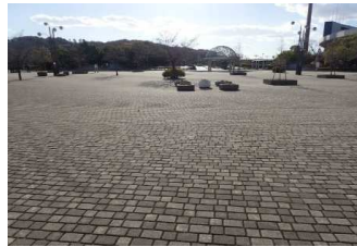
園路 舗装(インターロッキング) (倉敷スポーツ公園)
