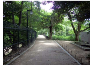
管理施設 フェンス(柵類) (後楽園)
