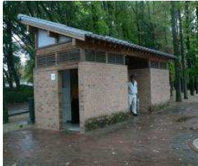
水泳場 便益施設 (総合グラウンド)
