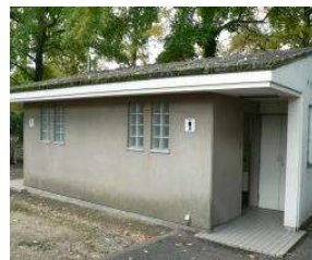
野球場 トイレ(外野西) (総合グラウンド)
