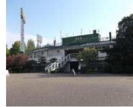
野球場 事務所本館 (総合グラウンド)
