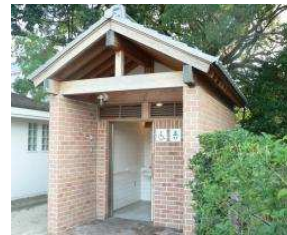
体育館 多目的トイレ (総合グラウンド)
