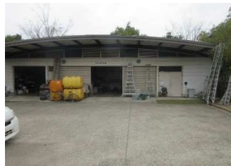
運動用具倉庫 (倉敷スポーツ公園)
