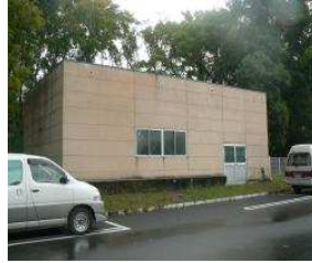
水泳場 機械室 (総合グラウンド)
