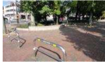
園路 舗装④ (総合グラウンド)
