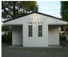
体育館 トイレ(ひょうたん池南) (総合グラウンド)
