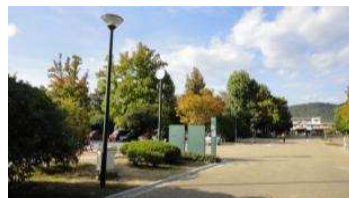
園路 時計・監視カメラ (総合グラウンド)
