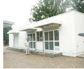
水泳場 管理棟 (総合グラウンド)
