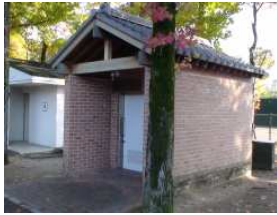
補助陸上競技場 多目的トイレ (総合グラウンド)
