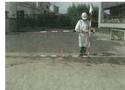
復旧延長写真 (終点)
