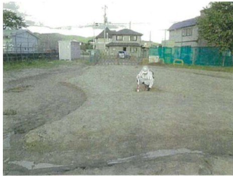
堆積状況写真 (遠景) No.5+10.0
