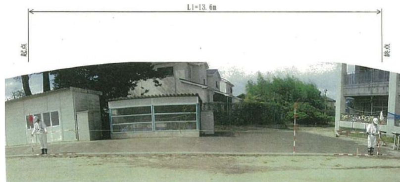
復旧延長写真 (全景)
