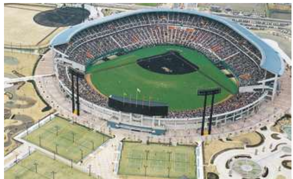
■倉敷スポーツ公園（マスカットスタジアム・倉敷市）■
