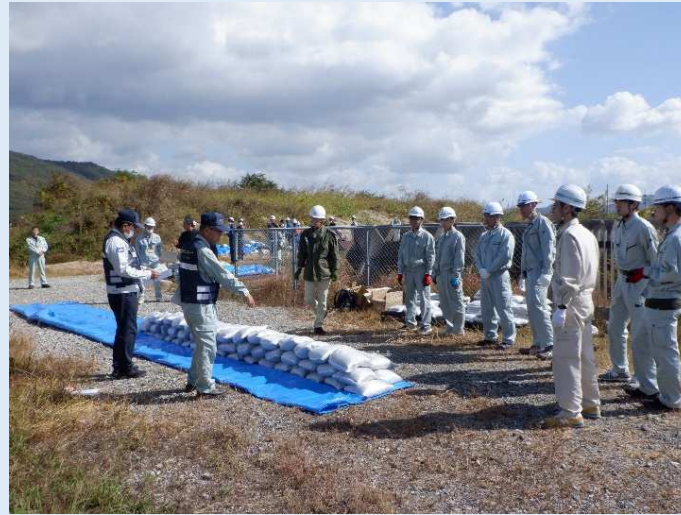
改良積み土のう工法
