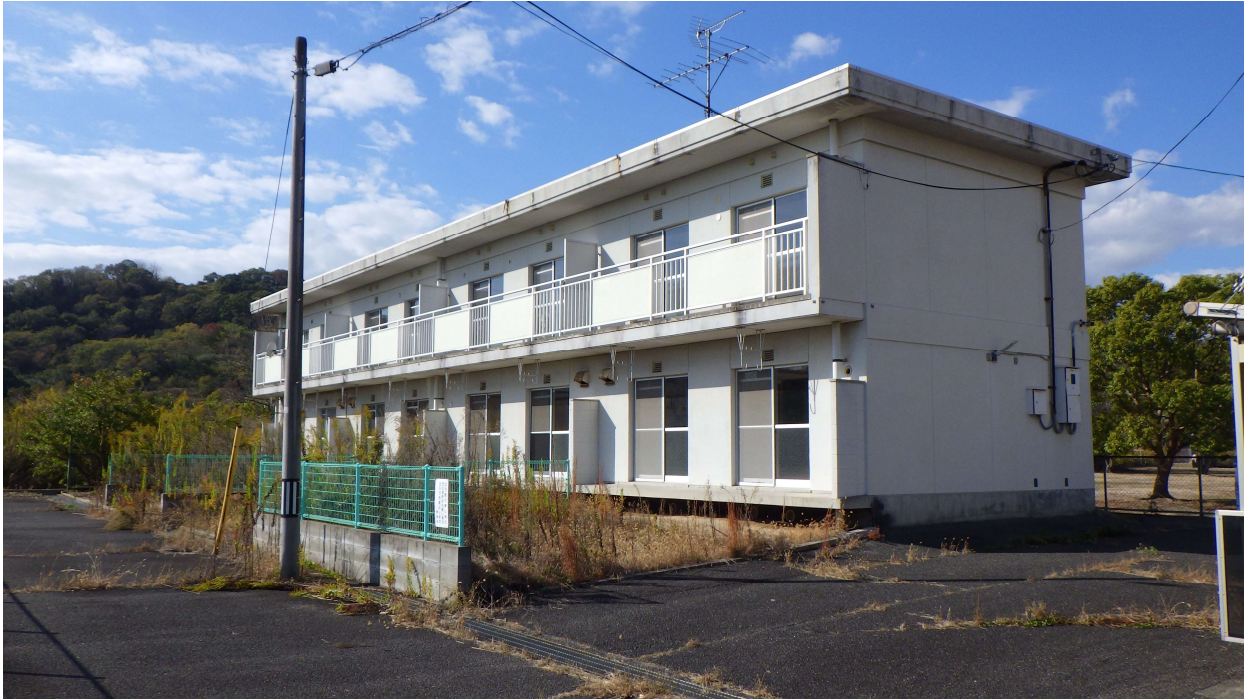
南東側より撮影
