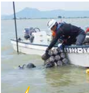
魚礁設置作業の様子
