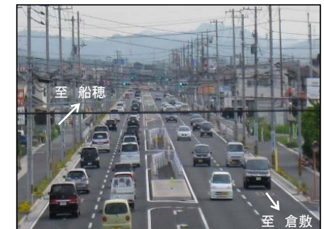
道路整備後の状況(バイパス部)
