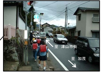
【幅員狭小・事故危険】 (都)大谷一宮線の旧道部(津山市)
