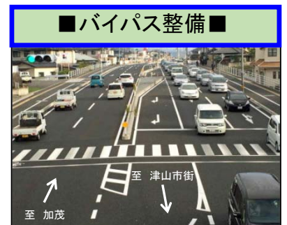
■バイパス整備■ (都)大谷一宮線(津山市)
