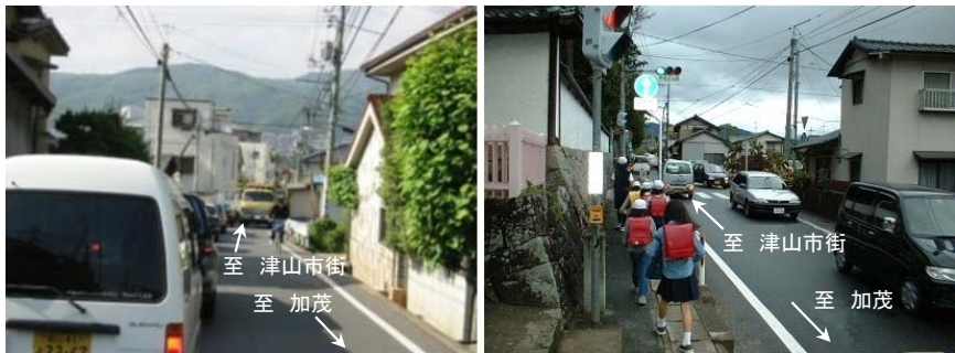
交通量が多く大型車とのすれ違い困難(旧道部) 歩道が未整備で狭い路肩を通学する児童(旧道部)
