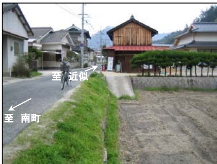
路肩が狭く歩道が未整備の現道
