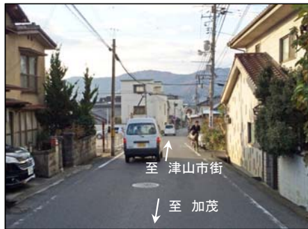
道路整備後の状況(旧道部)
