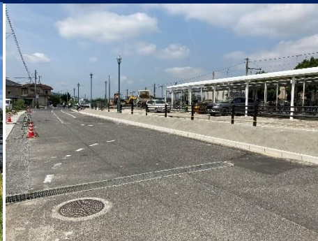
邑久駅(瀬戸内市) 【整備中】
