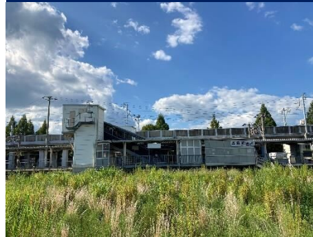
高島駅(岡山市) 【整備中】
