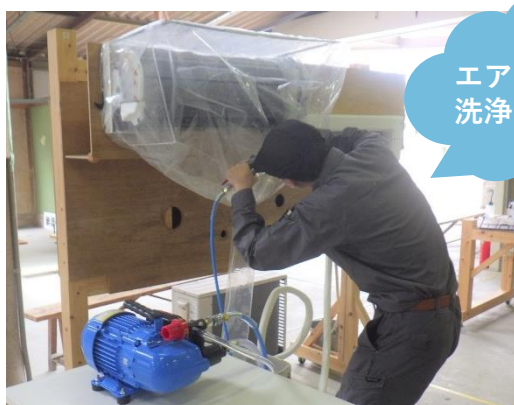
ルームエアコン洗浄実習
