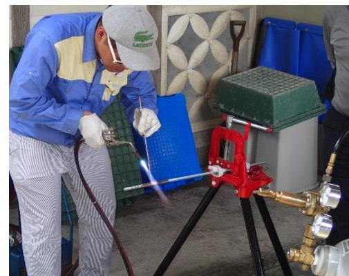
冷媒配管溶接実習
