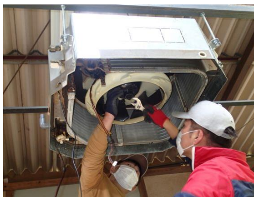
天井カセット型エアコン点検
