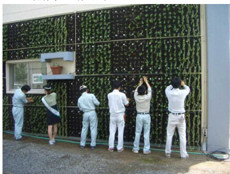
植栽中の状況
