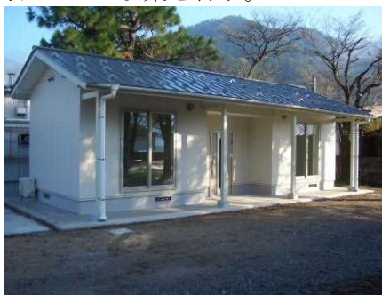
柿渋塗装の効果を見るテストハウス
