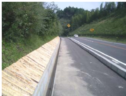
法面被覆パネル施工状況 (真庭市豊栄 国道313号)
