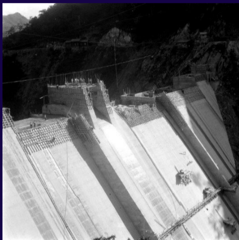
約3年間の建設期間
