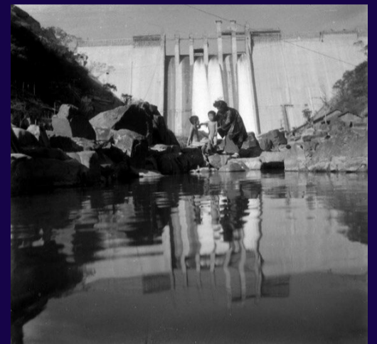
完成直前ダム
