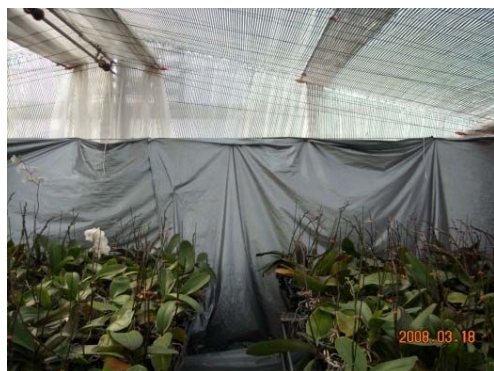
温室北面へ断熱資材を固定張り
