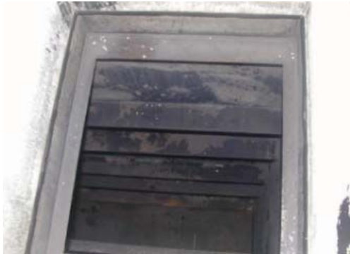
腐食抑制剤を使用している缶体
