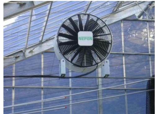
空気の流れをつくる循環扇
