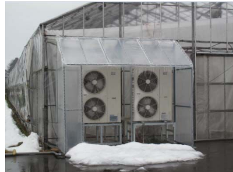
デフロスト水や積雪の影響に対応した適切な設置（例）
