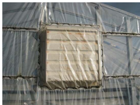
換気扇のシャッターを目張り
