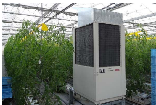
地下水熱源ヒートポンプ（室内機）
