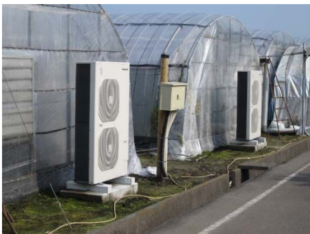
デフロスト水や積雪の影響に対応した適切な設置（例）
