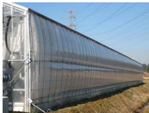
空気膜2重被覆（側面部）
