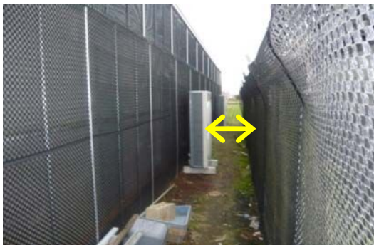
室外機の不適切な設置の例（ショートサーキットが発生しやすい）
