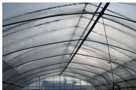
散水管より地下水を散水している様子
