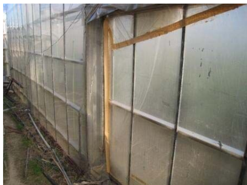
外張被覆の隙間を目張り
