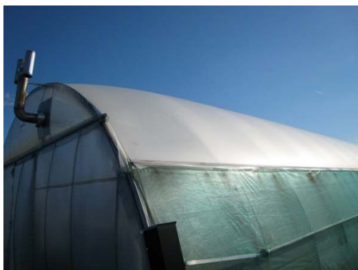
空気膜2重被覆（屋根部）
