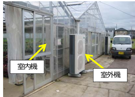
室内機と室外機の適切な設置例
