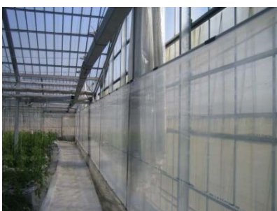
妻面のカーテンの隙間対策①
