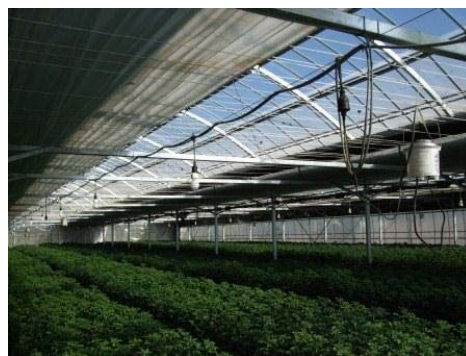
内張カーテンの自動開閉
