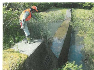
治山施設の点検
