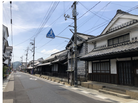
■宿伝統的建造物群保存地区（矢掛町）■
