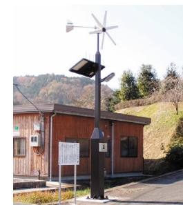
（発光ダイオードを使用した風力・太陽光発電街路灯 中央町）
